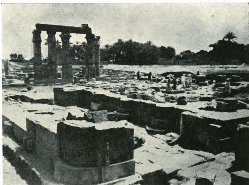
Fig. 29. — KIOSQUE NORD, VU DU NORD-OUEST.
